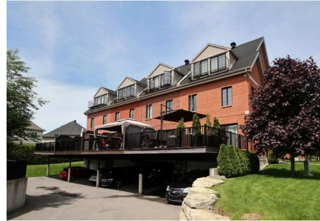
Figure 21 – Garage intérieur Source : Centris
