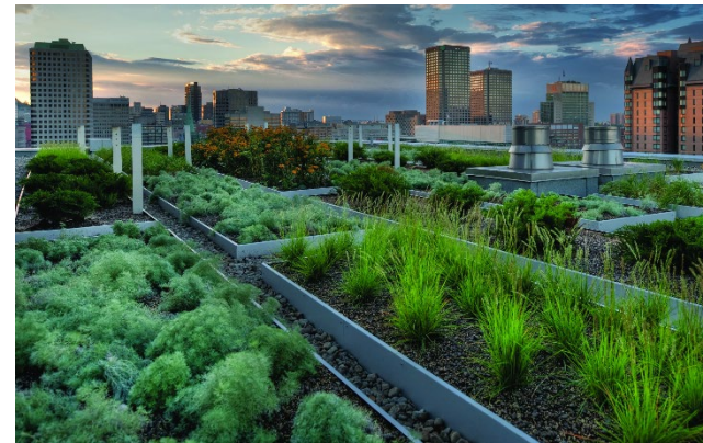
Figure 51 – Toit végétalisé, Montréal Source : Jean-Guy Lambert, Métro
