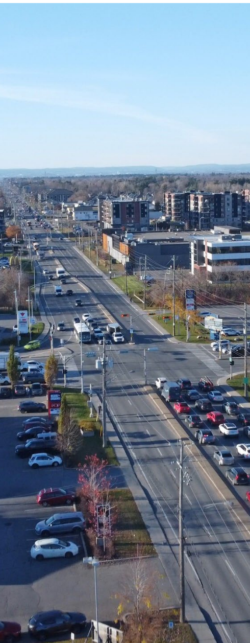
Figure 1 – Boulevard du Curé-Labelle Source : Ville de Blainville
