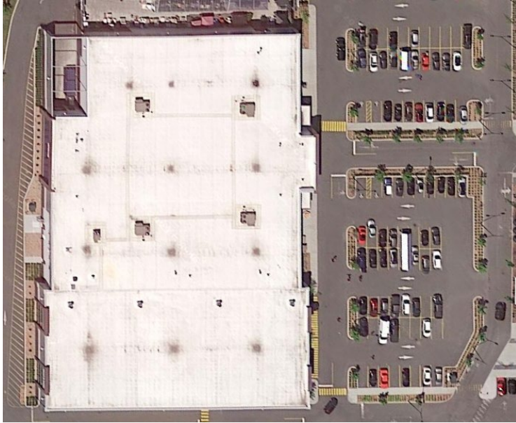
Figure 4. Le Smart Centre de la sortie 28 dispose de bâtiments aux toits pâles et de stationnements partiellement végétalisés (Google Earth, 2023).
