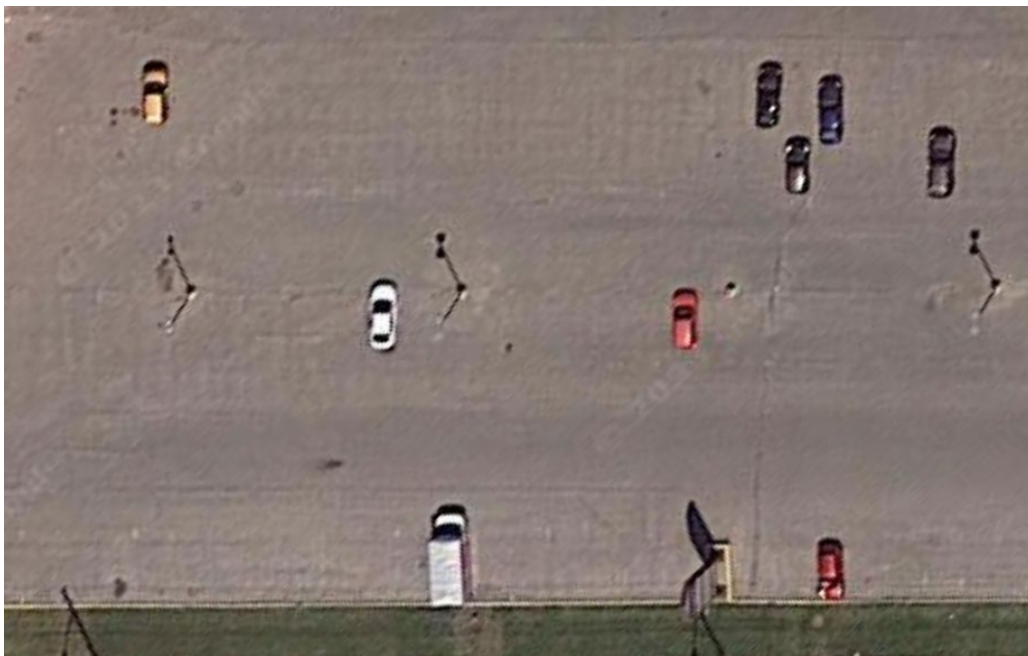
Figure 11 Comme plusieurs autres, le stationnement du centre commercial situé au 1356, boul. du Curé-Labelle est entièrement minéralisé et représente un îlot de chaleur important sur le territoire de la ville (Google Earth, 2023).
