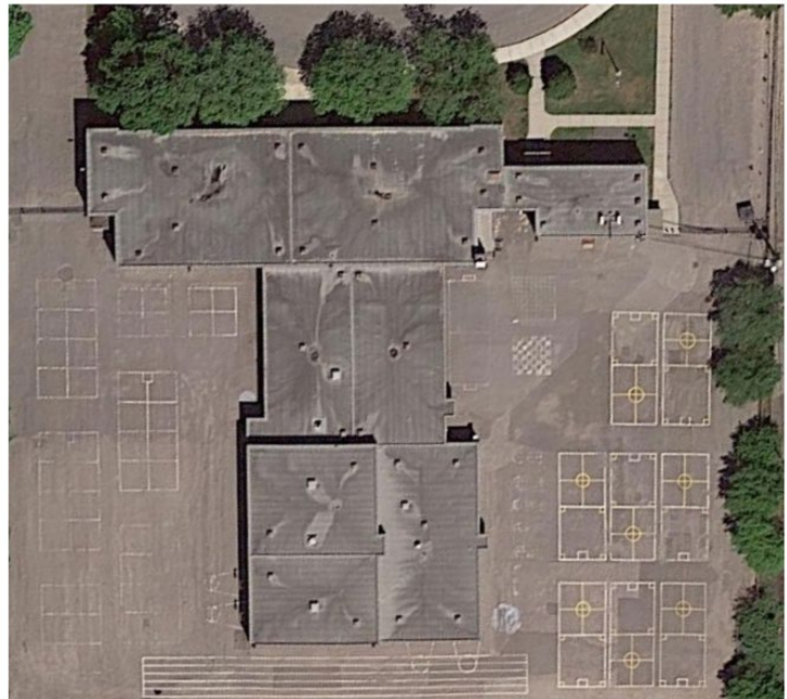
Figure 9 Exemple de l'école Notre-Dame-de-l'Assomption qui, en plus de posséder des toits plats foncés, a une cour presque entièrement minéralisée (Google Earth, 2023).
